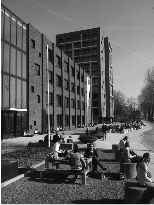
In 2013 werd het gebouwencomplex van De Driestar aan de Burgemeester Jamessingel uitgebreid. Het internaat uit de jaren zestig maakte plaats voor een nieuwe studentenflat.
